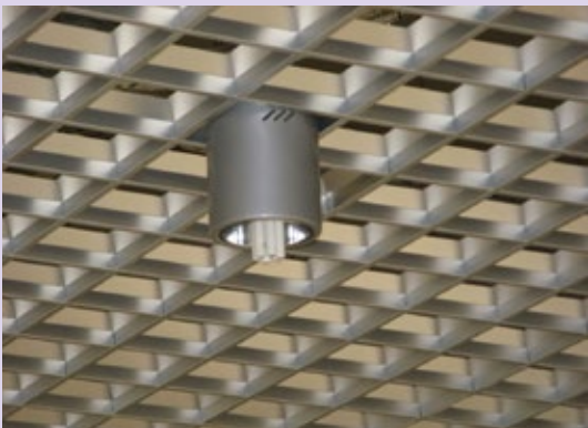
Układ profili nośnych sufitów rastrowych kielichowych dla oczka od 86 - 200 mm
