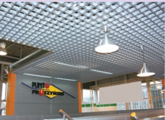
Układ profili nośnych sufitów rastrowych kielichowych dla oczka 75 mm
