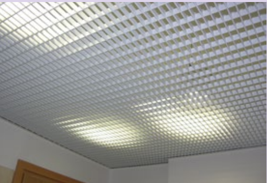
Układ profili nośnych sufitów rastrowych BASE 5
