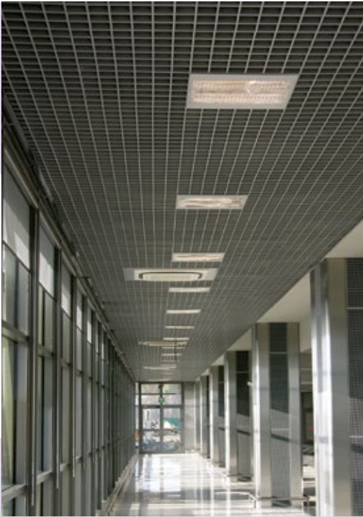
Układ konstrukcji sufitów H22 H40 H50 dla oczka od 86 - 200 mm
