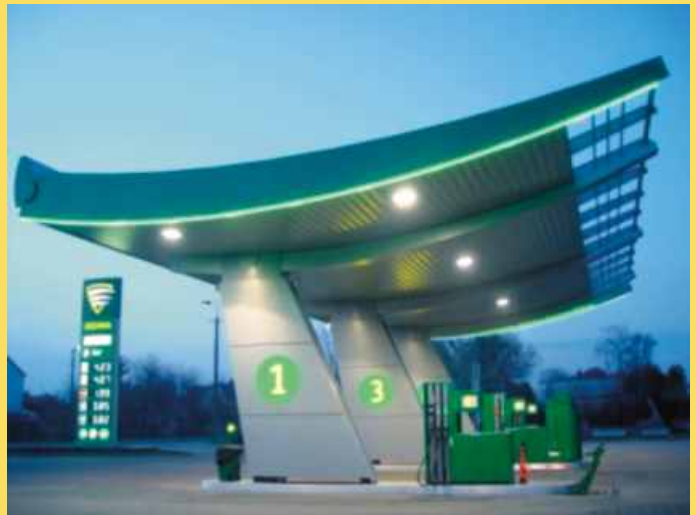
Wiaty stacji paliw – podsufitka z paneli Omega (wyk. VDS Europe)
