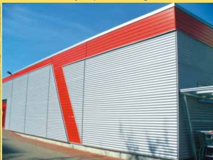
Detale elewacji wykonane z paneli OMEGA w połączeniu z okładziną z blachy.
