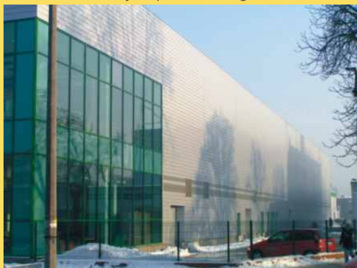
Elewacja z paneli Omega 190
