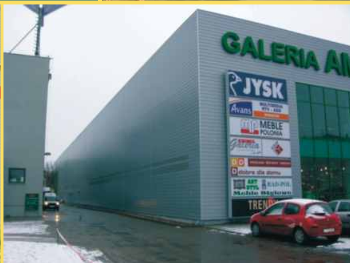
Elewacja z paneli Omega 190
