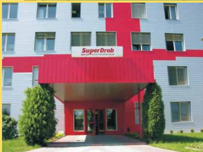
Elewacja z paneli Omega 200
