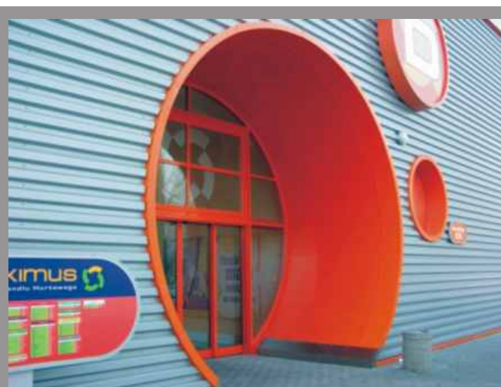
Panele OMEGA 100 na trawerszynie typu FLEX
